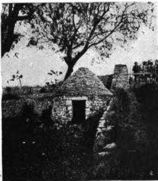
CARUPOLA DI RICOVERO PRESSO DIGNANO (canfa). È murato a secco. Si noti la forma ellittica che richiama i «trulli» pugliesi. La casita, come qui appare, è quasi sempre appoggiata a un muro (la masticca).
